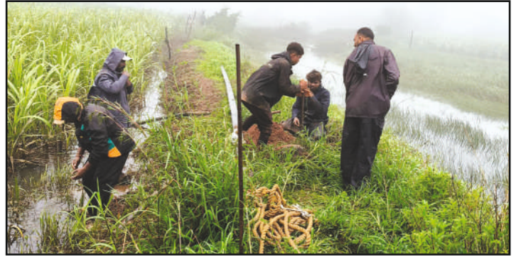
►► पार्ले उपकेंद्राला जोडणाऱ्या ३३ केव्ही वीजवाहिनीचा पुराच्या पाण्यामुळे पडलेला खांब उभारताना जनमित्र.
